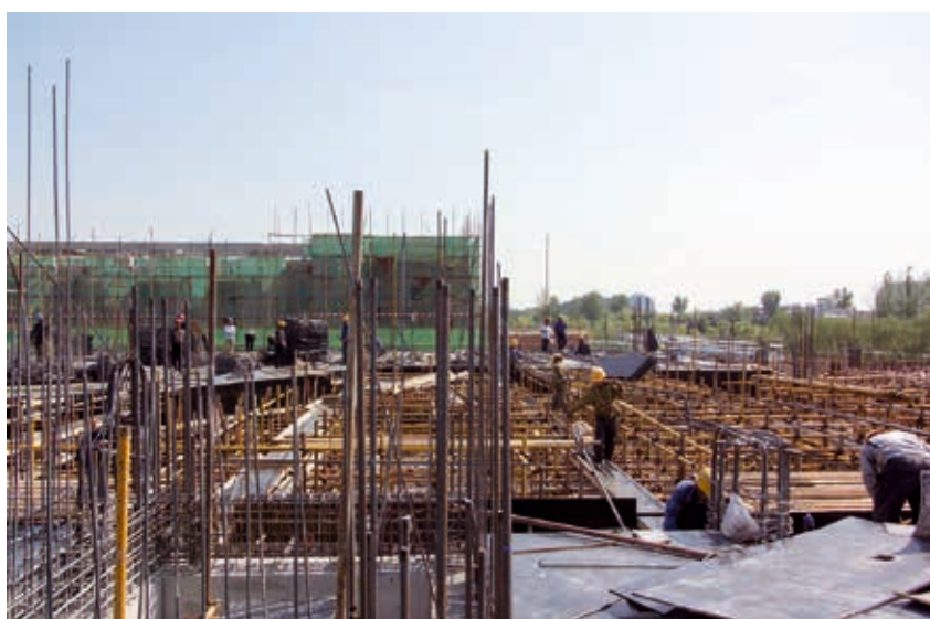
Byggeriet af Industriens Fonds Hus i Kina
